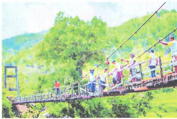
“สะพานอาาแหล่จะ” ขณะซ่อมแซม
