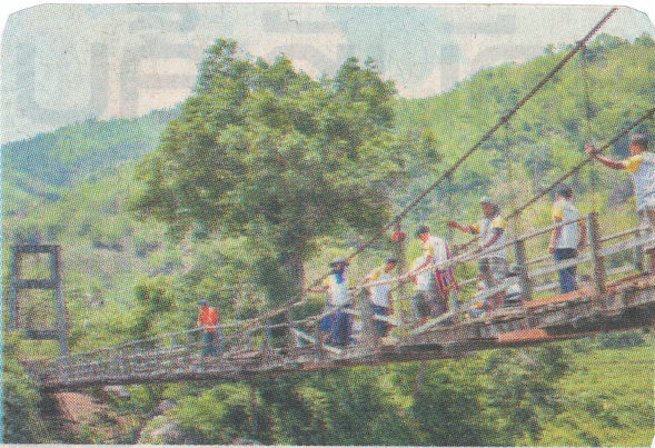
“สะพานฮาลอง” ขณะซ่อมแซม
