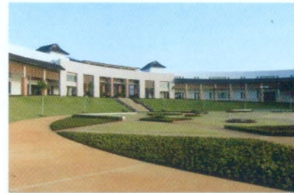
อาคารเรียนรวม (C1) และบริเวณลานเอนกประสงค์
