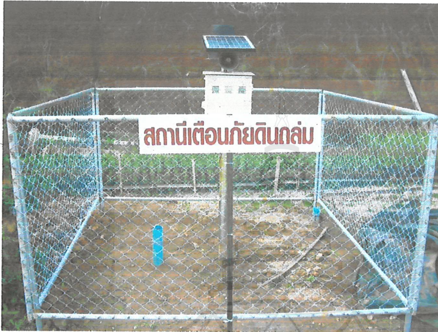
ภาพที่ 4-21 พื้นที่ติดตั้งอุปกรณ์เตือนภัยดินถล่มคอยแม่สลอง
