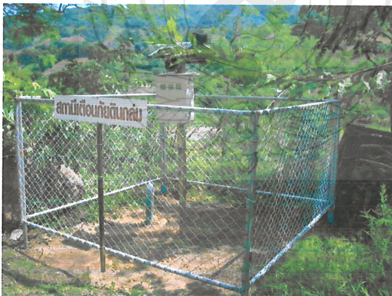
ภาพที่ 4-22 พื้นที่ติดตั้งอุปกรณ์เตือนภัยดินถล่มบ้านกิวสะไต
