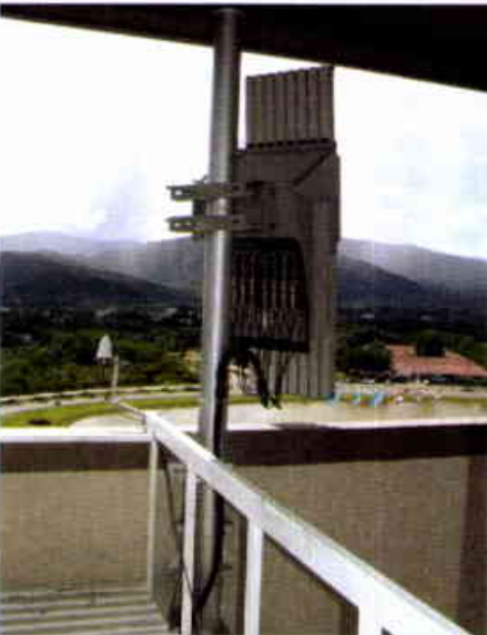
รูปที่ 4 Base Station Antenna และ GPS Unit ที่มหาวิทยาลัยแม่ฟ้าหลวง
