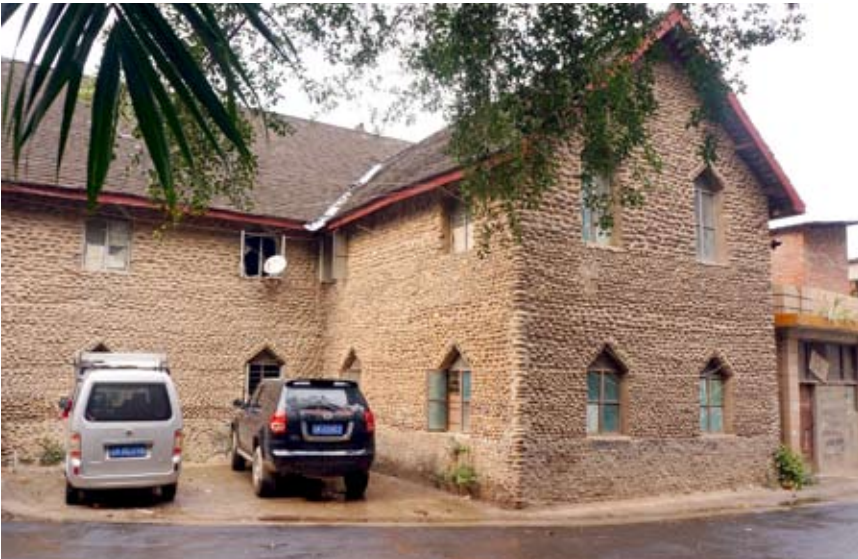
ปัจจุบันคริสตจักรหลังดินถูกเปลี่ยนให้กลายเป็นที่พักอาศัยของคนจีน
