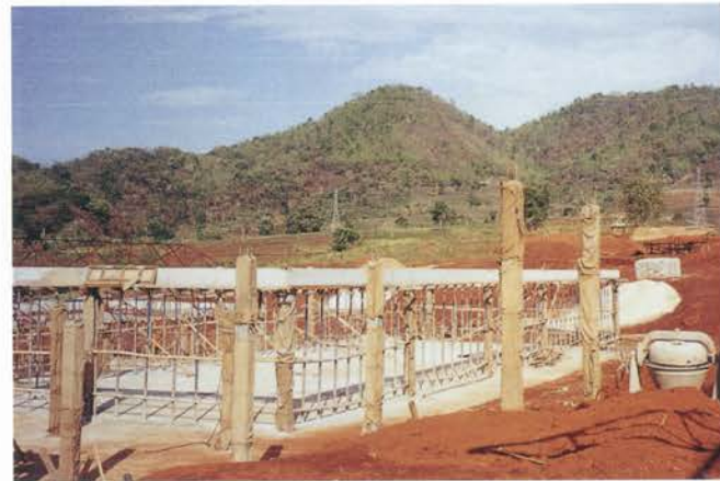
การก่อสร้างอาคารส่วนหน้า ณ บริเวณดอยแง่ม
