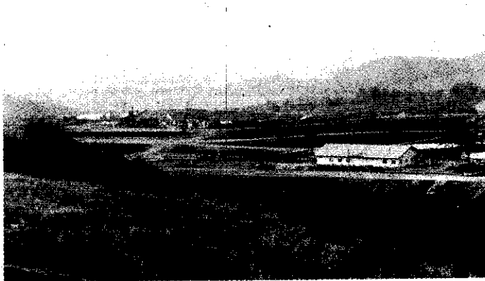
ส่วนหนึ่งของพื้นที่คอยแม่ฟ้าหลวงระหว่างปรับพื้นที่เพื่อสร้างอาคาร
